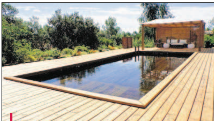
Point fort de cette piscine tout en bois : elle peut être montée en quatre jours. Selon la société, ses frais de fonctionnement seraient bien moins élevés que sur une piscine traditionnelle. / PHOTO DR
